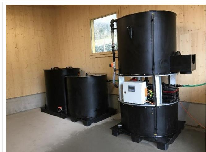
Fig. 1. Sistema di filtraggio a carbone attivo con il modulo per le particelle (a sinistra), il serbatoio di raccolta (al centro) e il modulo per i PF a carbone attivo (a destra).
