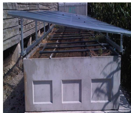
Fig. 2: Installation Biobac® à base de béton avec toit de pluie transparent. Image: canton de Vaud
